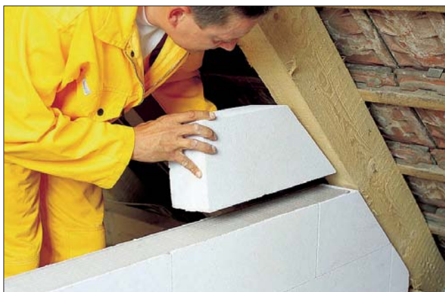
Рис. 1. Перегородочная стена из материала YTONG® внутри чердачного помещения
