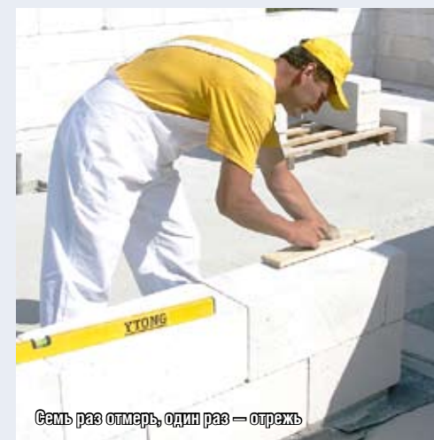
Небольшая масса ячеистых блоков легко позволяет вести кладку одному человеку
