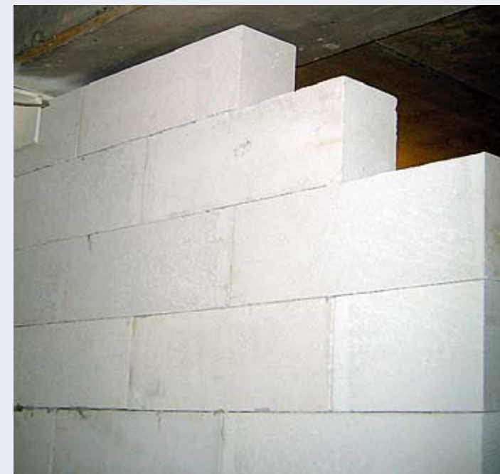
Укладка газобетонных блоков
